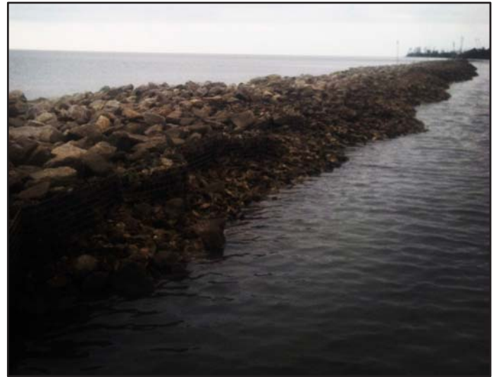
Đê Chắn Sóng của Đường Bờ Biển tại thời điểm thủy triều xuống ở Swift Tract, Alabama.
